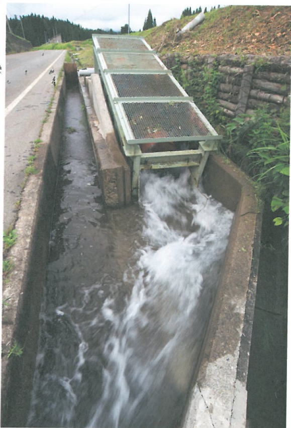
農業用水路で勢よく回るらせん型水車。ゴミが詰まりにくいのが特長
