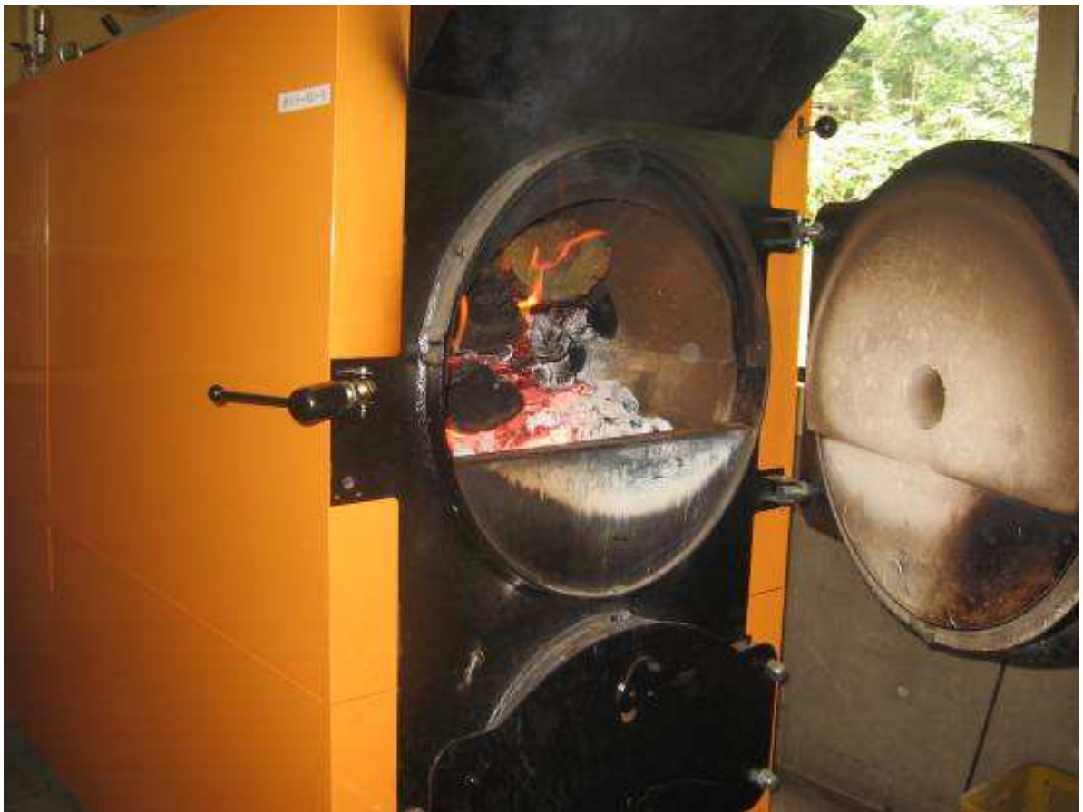
図-10 2次燃焼型の薪ボイラー
